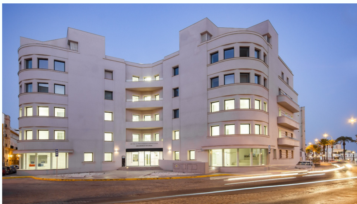
Rehabilitación el edificio el Olivillo
